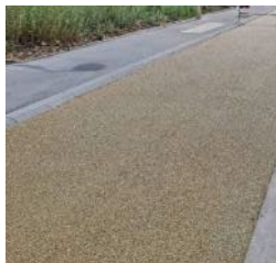
Enrobé clair (remontée cyclable)
